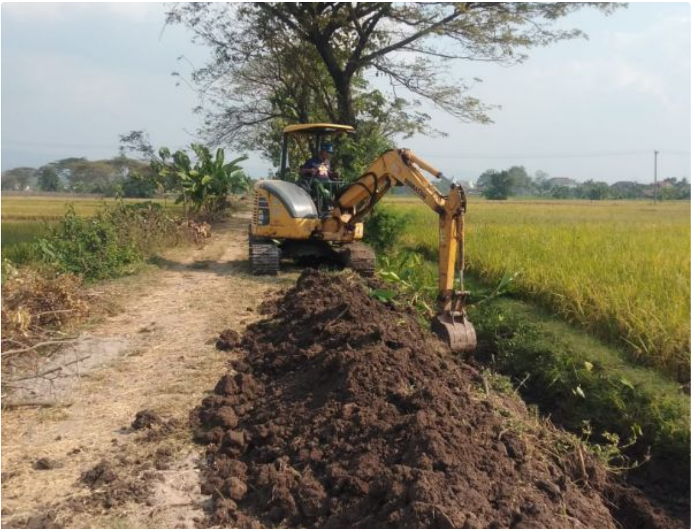
Alat Berat Diturunkan, Guna Kelancaran Pembuatan Talut Sasaran TMMD Reg 121
